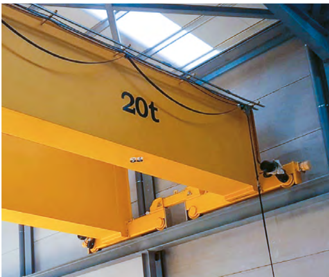
SUWNICA Z PODWÓJNYMI CZOŁOWNICAMI (OSIEM KÓŁ).
