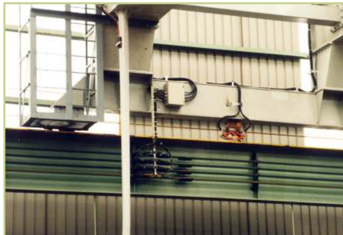
■ LÍNEA DE ALIMENTACIÓN DE PUENTE Y EQUIPOS DE SOLDADURA
