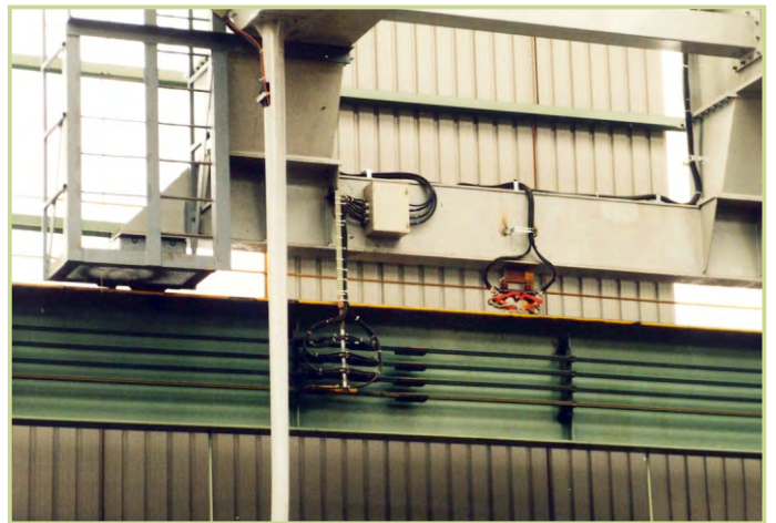
■ BRÜCKENZULEITUNG UND SCHWEISSANLAGEN
