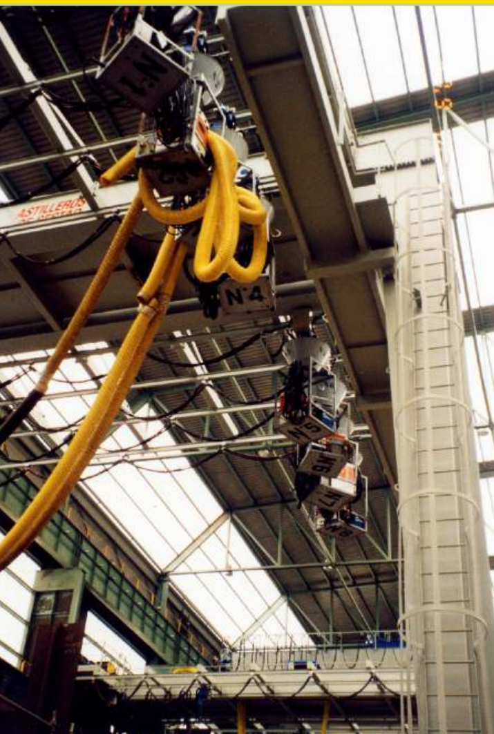
■ SISTEMA DE EXTRAÇÃO DE GASES DE SOLDAGEM
