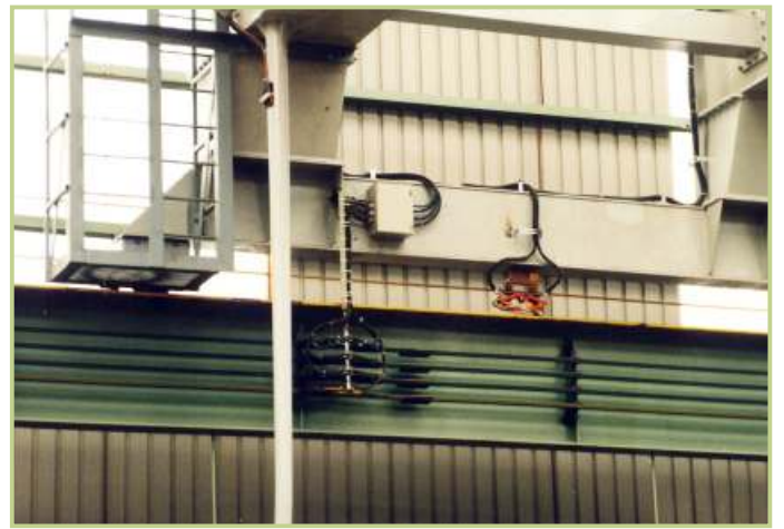
■ LINHA DE ALIMENTAÇÃO DA PONTE E EQUIPAMENTOS DE SOLDAGEM
